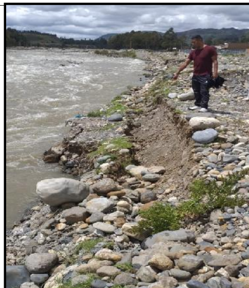
Imagen 3: Vista del Rio Santa donde se observa el daño ocasionado a la estructura de protección debido al incremento del flujo
